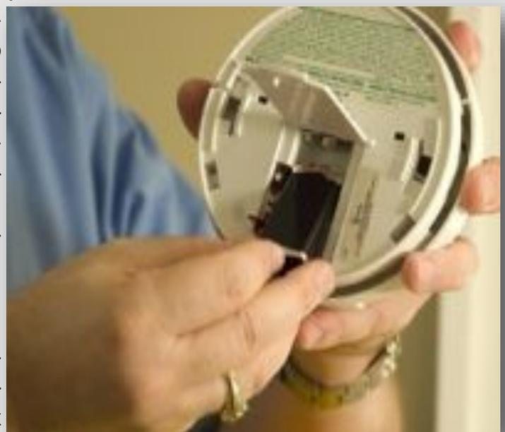
ния производится один раз в год и не представляет собой ничего сложного. Извещатель снимается с потолка, достается использованный элемент и вставляется новый. Одновременно нужно очистить дымовую камеру от пыли с помощью пылесоса.
